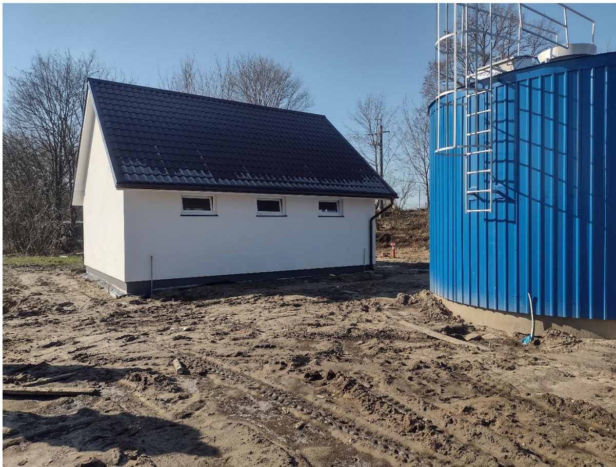
Rycina 29. Infrastruktura wodno-kanalizacyjna w miejscowości Jamrzyno-Ochodza-Motarzyno
