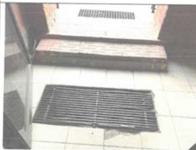
Fot.4. Wykonać naprawy okładzin w obrębie wycieraczki na klatce schodowej przynależnej do dawnej szkoły
