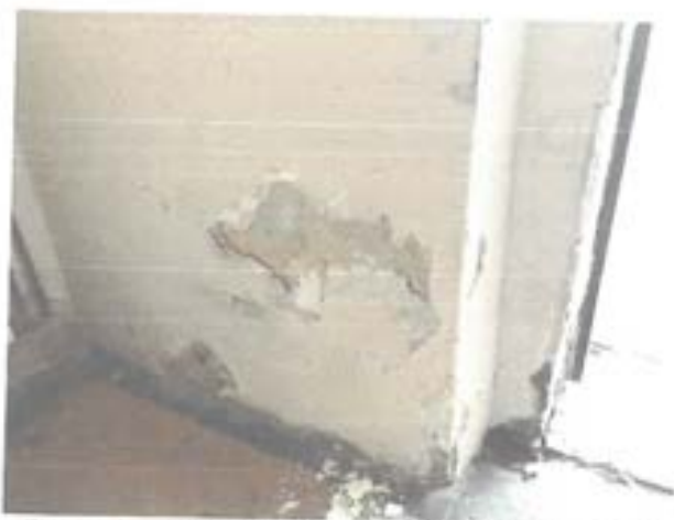
Fot.7. Odparzenia tynków na klatce schodowej od strony posterunku – zalecana naprawa ścian wraz z malowaniem
