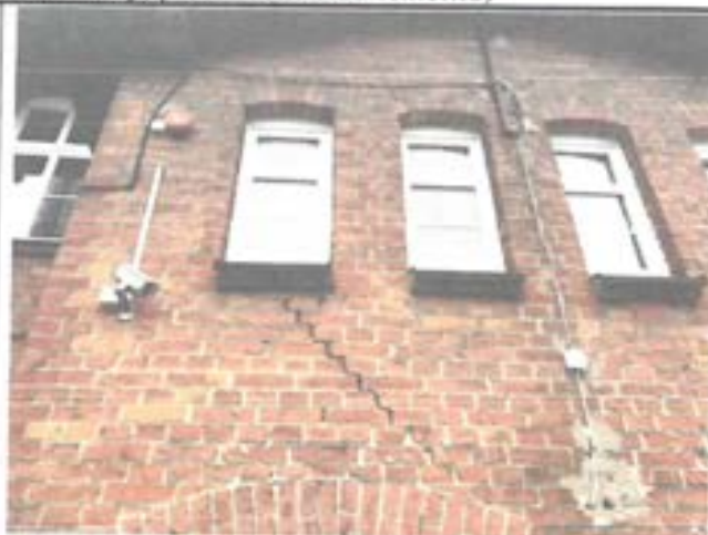
Fot.2. Widoczne pęknięcie w ścianie – zalecana naprawa
