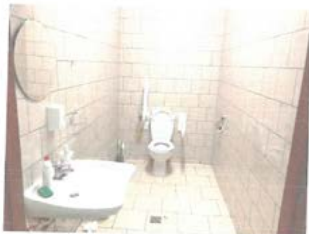
Fot.10. Toaleta dla osób niepełnosprawnych - dostosować wyposażenie toalety poprzez: zainstalowanie instalacji przyzywowej oraz montaż uchwyty w obrębie umywalki
