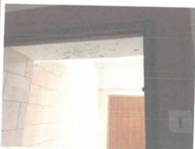
Fot.11. Wykonać naprawy tynków nad wejściem do toalety na parterze budynku w części po byłej szkole
