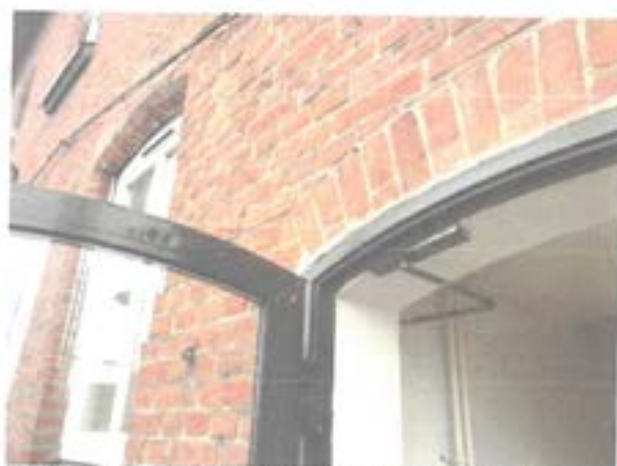
Fot.6. Uszkodzony samozamykacz drzwi wejściowych do klatki wejściowej od strony posterunku - zalecana naprawa lub wymiana
