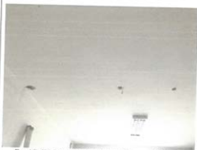
Fot.12. Wykonać naprawy tynków na suficie po demontażu krat w części po byłej szkole
