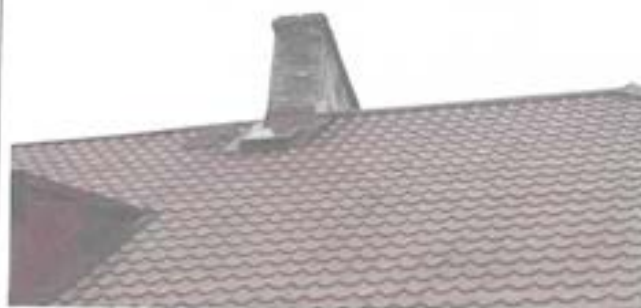
Fot.1. Zalecana naprawa tynków na kominie powyżej dachu
