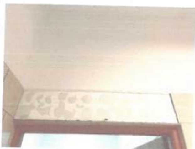
Fot.9. Uzupelnnić okładziny ściany w toalecie na parterze budynku
